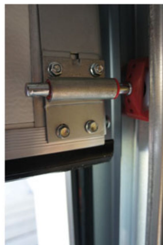
16. OBS! DET NEDERSTA GÅNGJÄRNSBESLAGET SKALL MONTERAS SÅ ATT DET ÖVERLAPPAR PÅ ALUMINIUM- PROFILEN (Tröskellisten med gummitätning) SOM BILDEN VISAR. OM BESLAGET MONTERAS OVANFÖR TRÖSKELLISTEN ÄR RISKEN ATT GUMMITÄTNINGEN KILAR FAST MOT DEN VERTIKALA KARMTÄTNINGEN NÄR PORTEN ÖPPNAR OCH STÄNGER.
