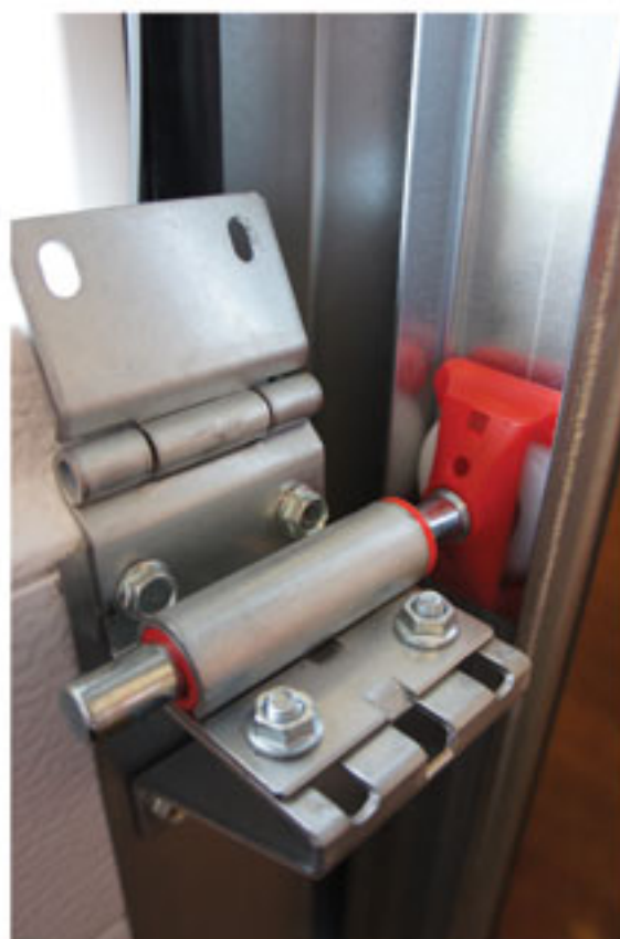
MONTERA DET ÖVRE BUSSNINGSBESLAGET MED STYRRULLEN PÅ BÅDA SIDORNA AV DET NEDERSTA PORTELEMENTET.
