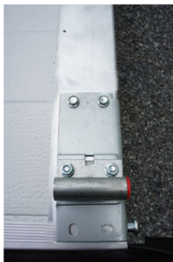
16. OBS! DET NEDERSTA GÅNGJÄRNSBESLAGET SKALL MONTERAS SÅ ATT DET ÖVERLAPPAR PÅ ALUMINIUM- PROFILEN (Tröskellisten med gummitätning) SOM BILDEN VISAR. OM BESLAGET MONTERAS OVANFÖR TRÖSKELLISTEN ÄR RISKEN ATT GUMMITÄTNINGEN KILAR FAST MOT DEN VERTIKALA KARMTÄTNINGEN NÄR PORTEN ÖPPNAR OCH STÄNGER.
